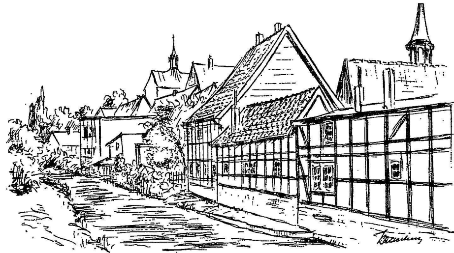
Wasserzucht, Nordseite, als der Stadtgraben noch Wasser führte. — Zeichn. W. Kaemling
