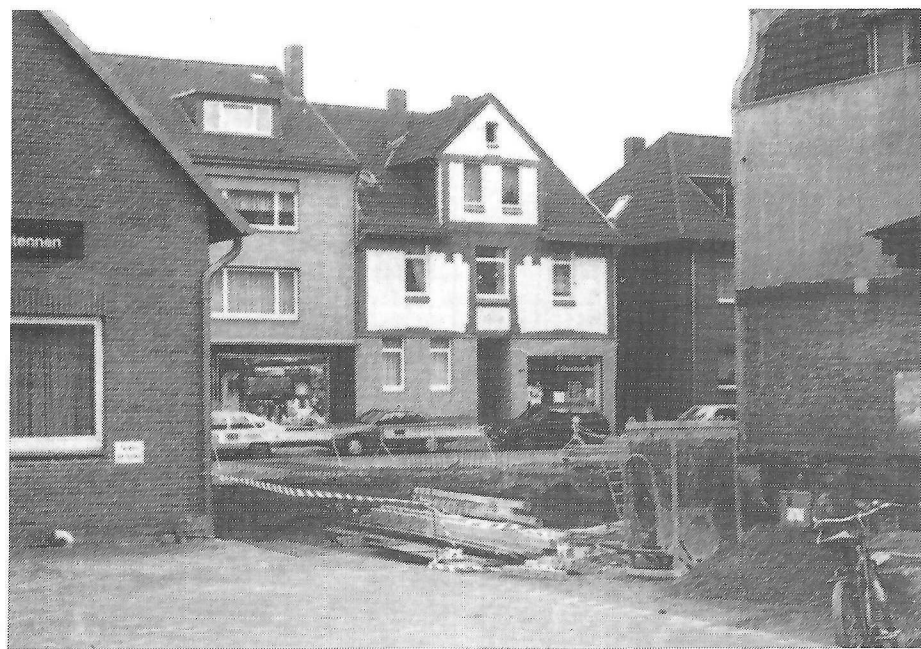
Eine Baulücke an der Langen Straße. Hier standen einst zwei Häuser. Auf beiden Hausgrundstücken wurde ein Holzbrunnen freigelegt.
