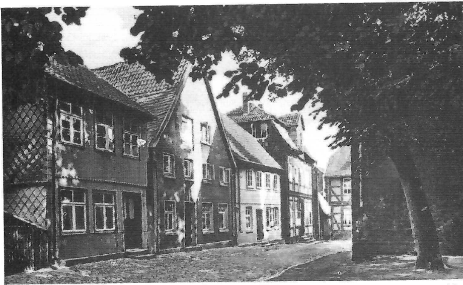
Auch Stadtanlagen sind Baudenkmäler. Diese altbekannte Häuserzeile „Unter den Linden“ in Wunstorf begrenzte einst die Stadt zum Stadtgraben hin. Wahrscheinlich ohne lange darüber nachzudenken, wurden eines Tages die Straßennamen verschoben. Wunstorf verlor seine Straßenbezeichnung „Unter den Linden“ und überließ sie Idensen. Die „Kastanienallee“ wurde Blumenau / Lieth überlassen. Man kam so ohne Schwierigkeiten durch die Gebiets- und Verwaltungsreform. Die Reihenfolge: Häuser weg, Linden weg, Name weg. Es blieb zum Glück das Bild von Alt-Wunstorf, vertraut im Schatten der Stadtkirche, eine Bebauung zur Stiftsstraße hin, wo noch das Fachwerkaus Nr. 2 steht.
