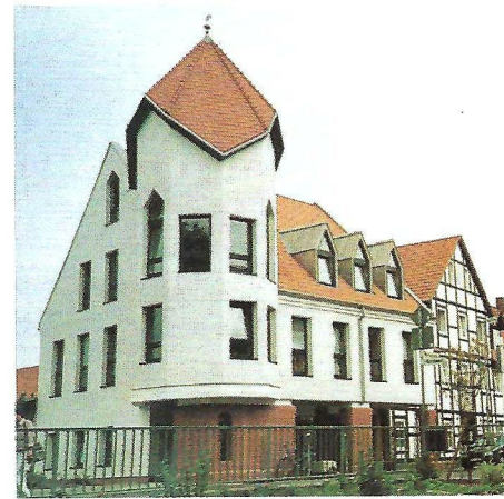
Torsituation zur Nordstraße
