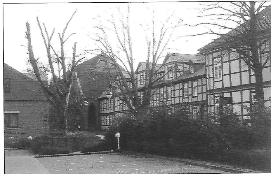
Die rückwärtige Südstraßenfront des LKH, ehemals Hauptgebäude der Kasernenanlage
